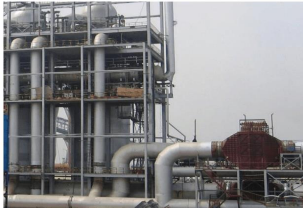
Рисунок 5 – Системы утилизации тепла отходящих дымовых газов
